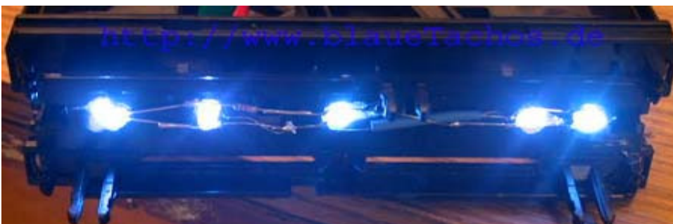
Hier eine Leuchtprobe des halb umgebauten Heizungsfeldes.
